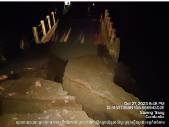
Oct 27, 2023 6:49 PM 12.41537396N 105.6669432E Stueng Trang Cambodia ស្ពានបេតុង វាលត្រដក់ពង មានទទឹង5m បណ្តោយ12m បាក់ស្រុតដោយជំនន់ទឹកភ្លៀងនៅព្រឹកថ្ងៃទី27-10-2023 ស្ថិតក្នុងឃុំទួលសំបូរ ស្រុកស្ទឹងត្រង់ ខេត្តកំពង់ចាម
